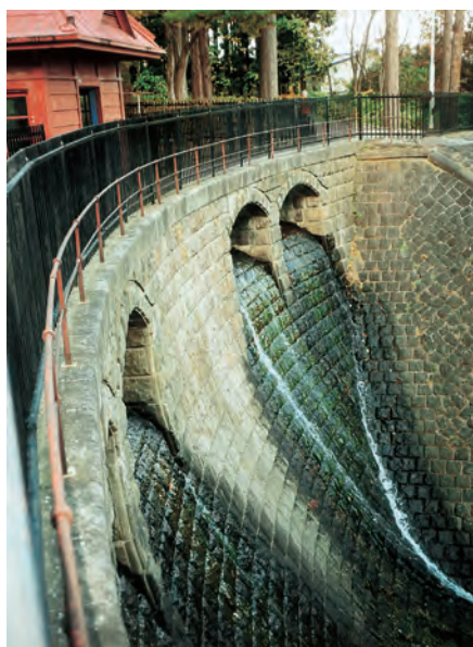
日本最古のアーチ式ダム（明治42年） むつ市にある。技術の高さを示している。
