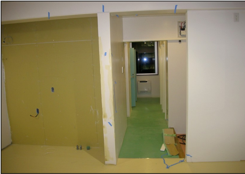
位置: 2F 水廻り室 撮影日: 令和3年12月8日
