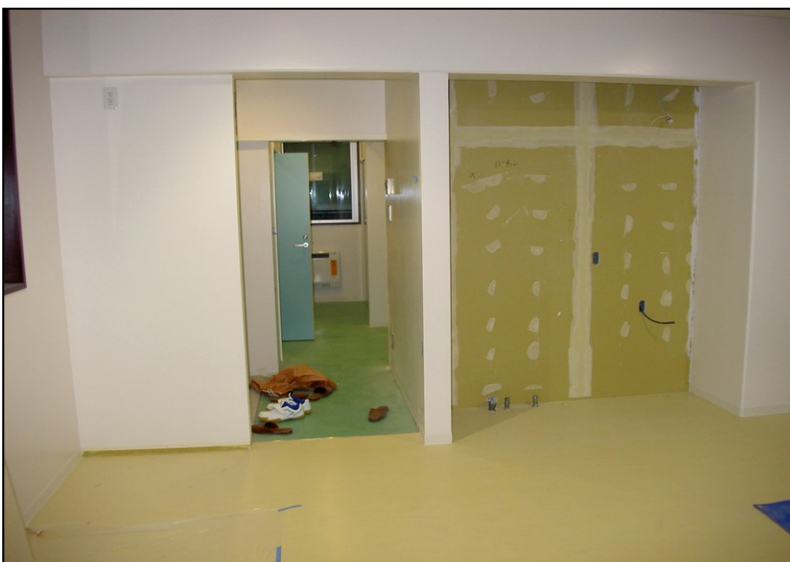
位置: 1F 水廻り室 撮影日: 令和3年12月8日
