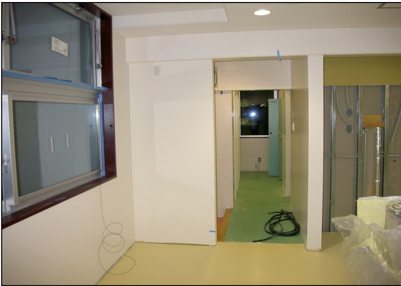
位置： 3F 水廻り室 撮影日： 令和3年12月8日
