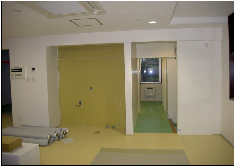
位置: 2F 水廻り室 撮影日: 令和3年12月7日
