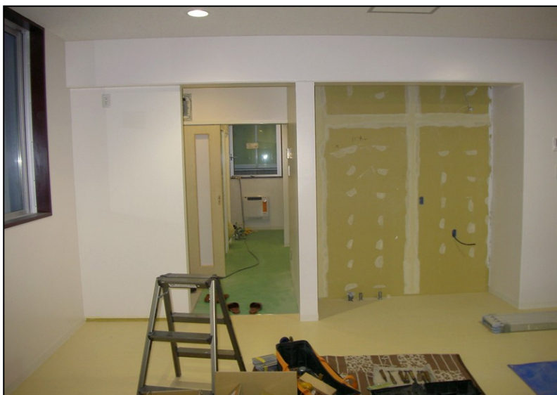
位置: 1F 水廻り室 撮影日: 令和3年12月7日 設備工事: 配管保温
