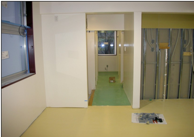
位置： 3F 水廻り室 撮影日： 令和3年12月7日
