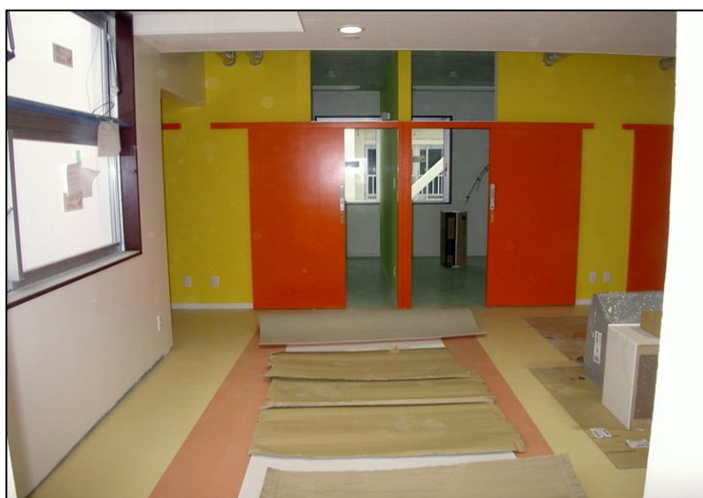
位置: 2F 交流スペース 撮影日: 令和3年12月6日 建具工事: 木製建具吊込み
