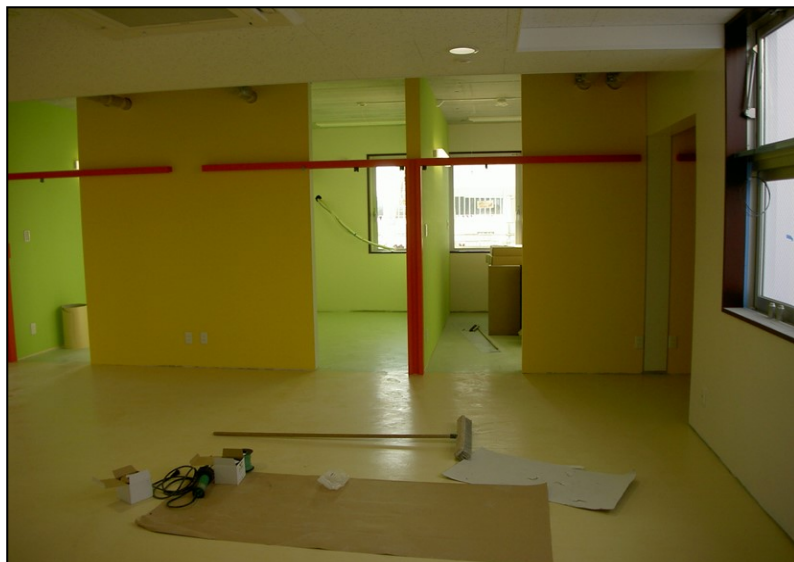
位置: 3F 交流スペース 撮影日: 令和3年12月6日 内装工事: 床長尺塩ビシート張り
