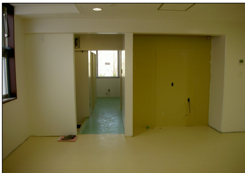
位置: 3F 水廻り室 撮影日: 令和3年12月6日 内装工事: 床長尺塩ビシート張り
