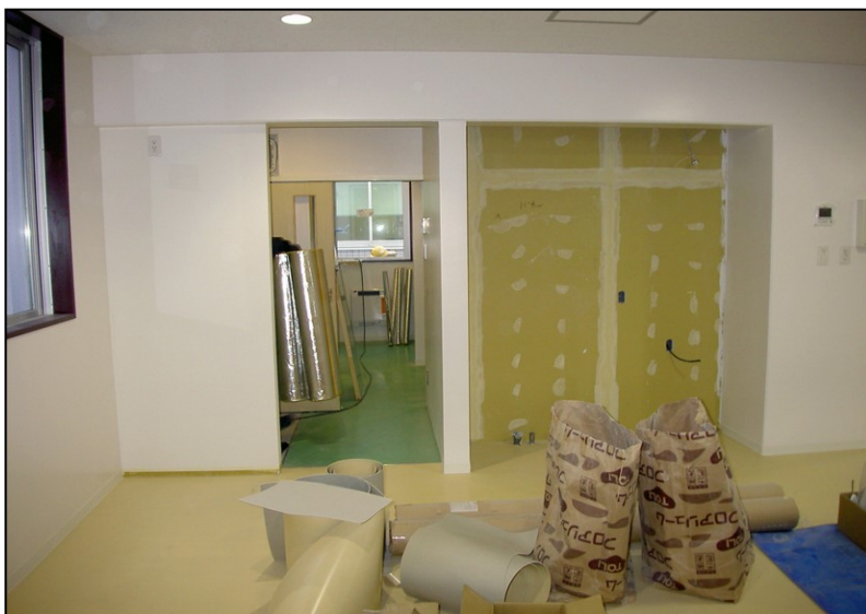
位置: 1F 水廻り室 撮影日: 令和3年12月6日 設備工事: 配管保温
