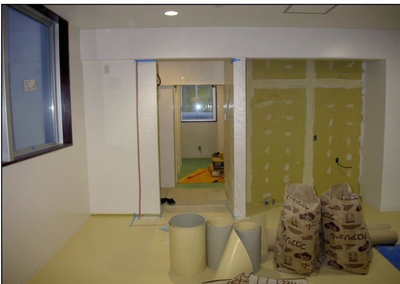
位置: 1F 水廻り室 撮影日: 令和3年12月2日
