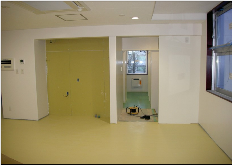
位置: 2F 水廻り室 撮影日: 令和3年12月2日
