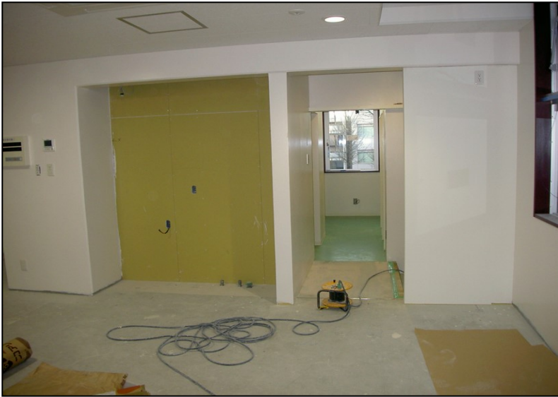
位置: 2F 水廻り室 撮影日: 令和3年11月30日
