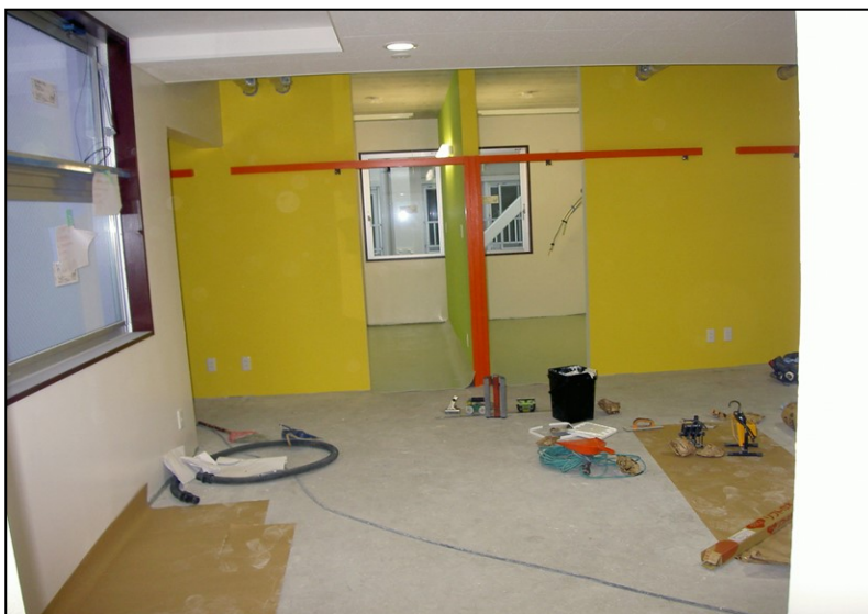
位置: 2F 交流スペース 撮影日: 令和3年11月30日 内装工事:床長尺塩ビシート張り
