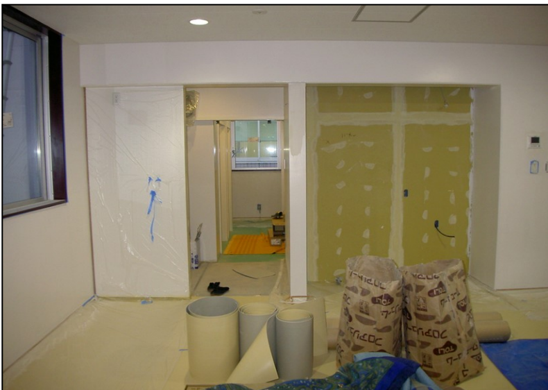
位置: 1F 水廻り室 撮影日: 令和3年11月30日
