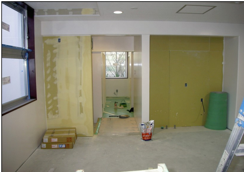
位置: 3F 水廻り室 撮影日: 令和3年11月30日 内装工事:クロス下地処理
