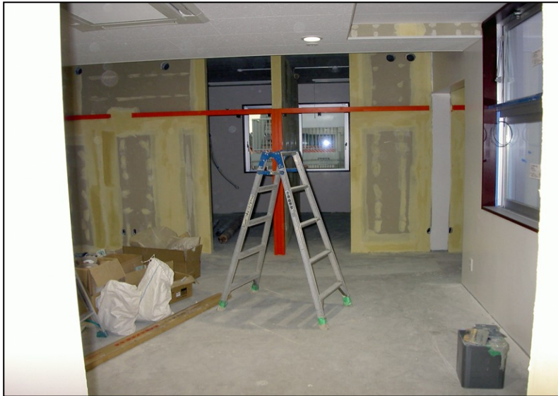
位置: 3F 交流スペース 撮影日: 令和3年11月29日 内装工事: クロス下地処理
