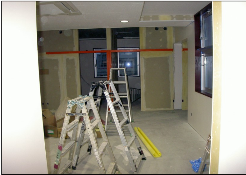
位置: 3F 交流スペース 撮影日: 令和3年11月25日 内装工事: クロス下地処理 塗装工事: 塗装
