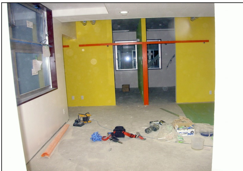
位置: 2F 交流スペース 撮影日: 令和3年11月25日 内装工事: クロス張り
