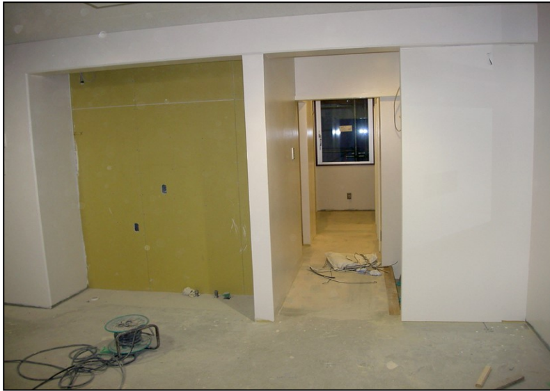
位置: 2F 水廻り室 撮影日: 令和3年11月25日 内装工事: クロス張り 塗装工事: 塗装
