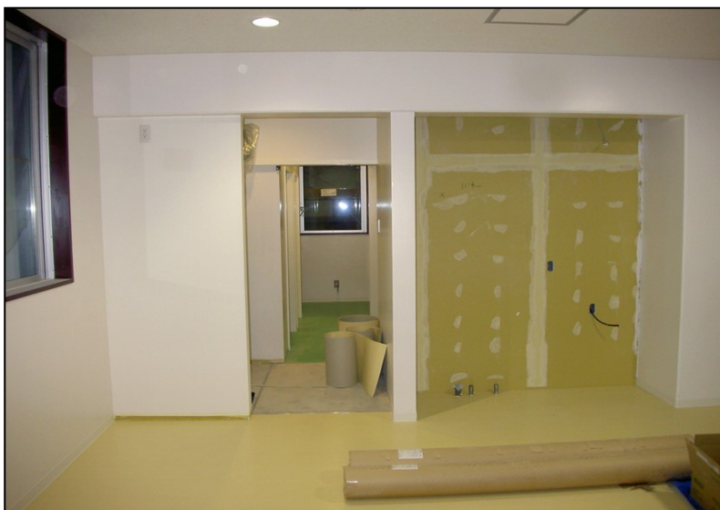
位置: 1F 水廻り室 撮影日: 令和3年11月25日 内装工事: 床長尺塩ビシート張り
