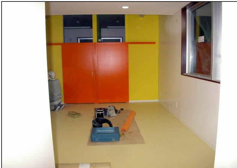
位置: 1F 交流スペース 撮影日: 令和3年11月25日 内装工事: 床長尺塩ビシート張り 建具工事: 木製建具釣込み
