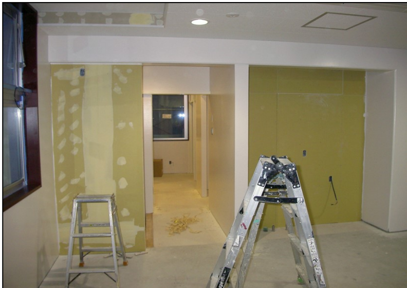
位置: 3F 水廻り室 撮影日: 令和3年11月25日 内装工事: クロス下地処理 塗装工事: 塗装
