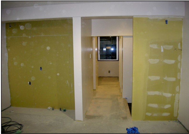
位置: 2F 水廻り室 撮影日: 令和3年11月22日
