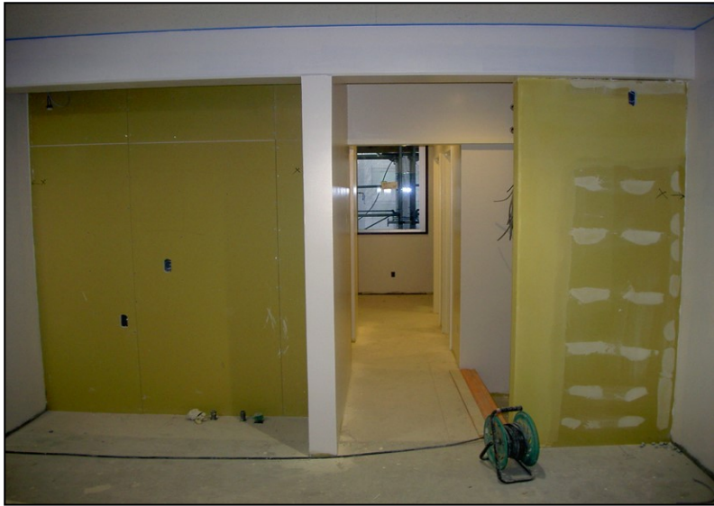
位置: 2F 水廻り室 撮影日: 令和3年11月18日 塗装工事: 塗装
