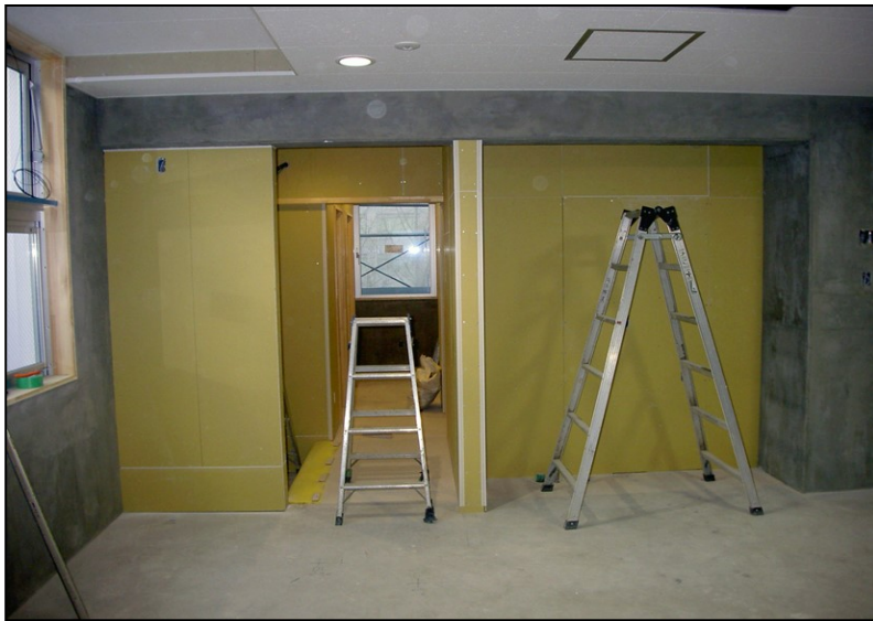
位置: 3F 水廻り室 撮影日: 令和3年11月18日
