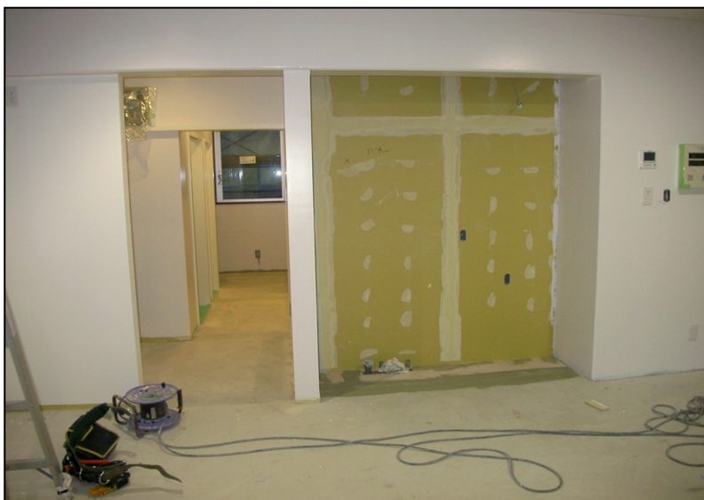
位置: 1F 水廻り室 撮影日: 令和3年11月18日
