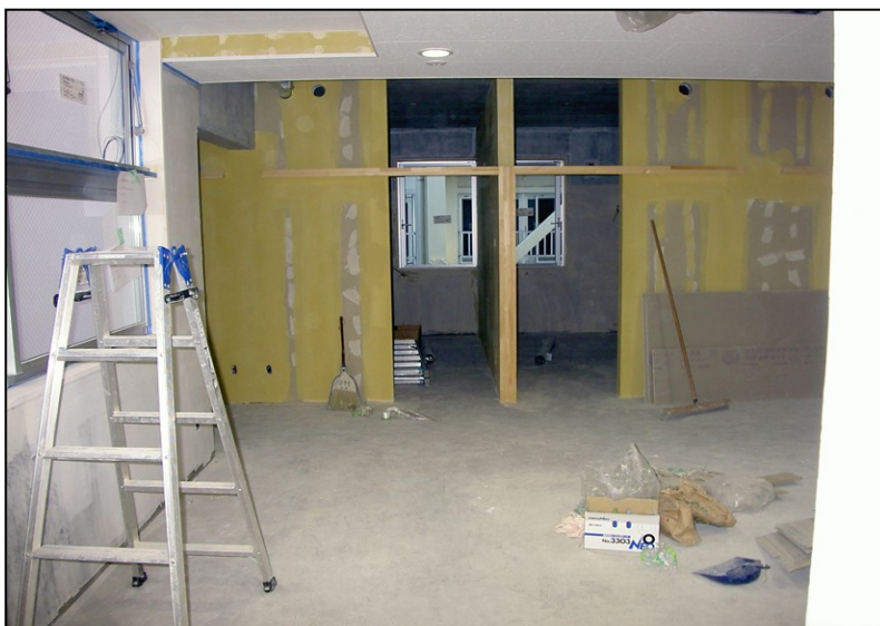
位置: 2F 交流スペース 撮影日: 令和3年11月17日 塗装工事: 塗装
