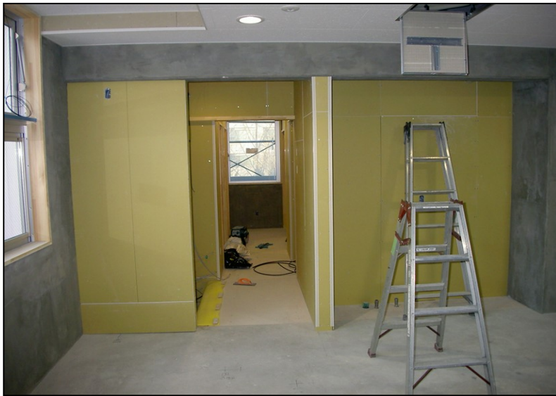
位置: 3F 水廻り室 撮影日: 令和3年11月17日
