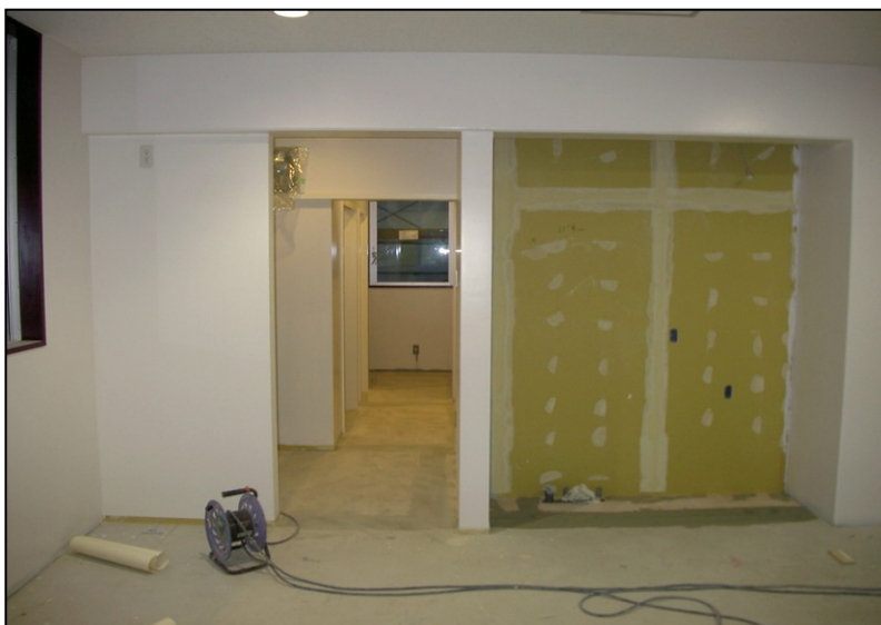
位置: 1F 水廻り室 撮影日: 令和3年11月17日
