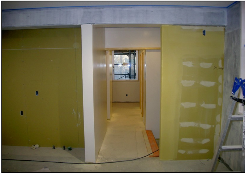
位置: 2F 水廻り室 撮影日: 令和3年11月17日 塗装工事: 塗装
