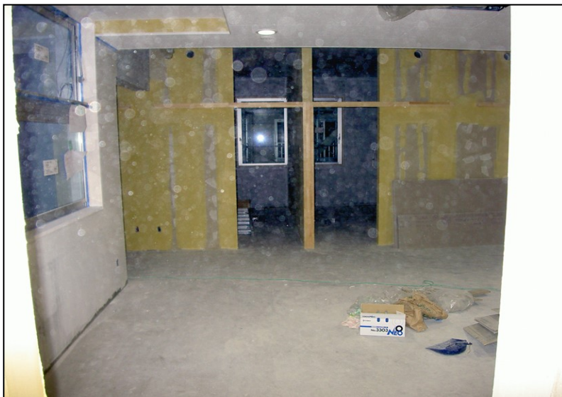
位置: 2F 交流スペース 撮影日: 令和3年11月16日 塗装工事: 塗装
