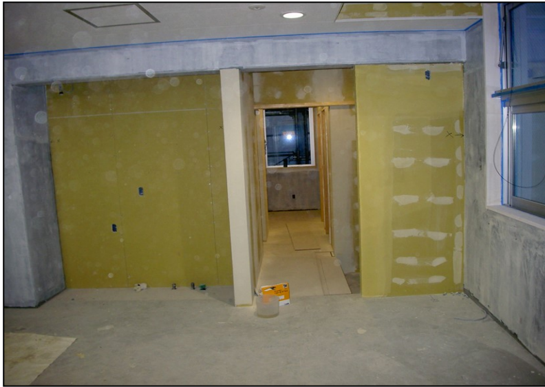
位置: 2F 水廻り室 撮影日: 令和3年11月16日 塗装工事: 塗装
