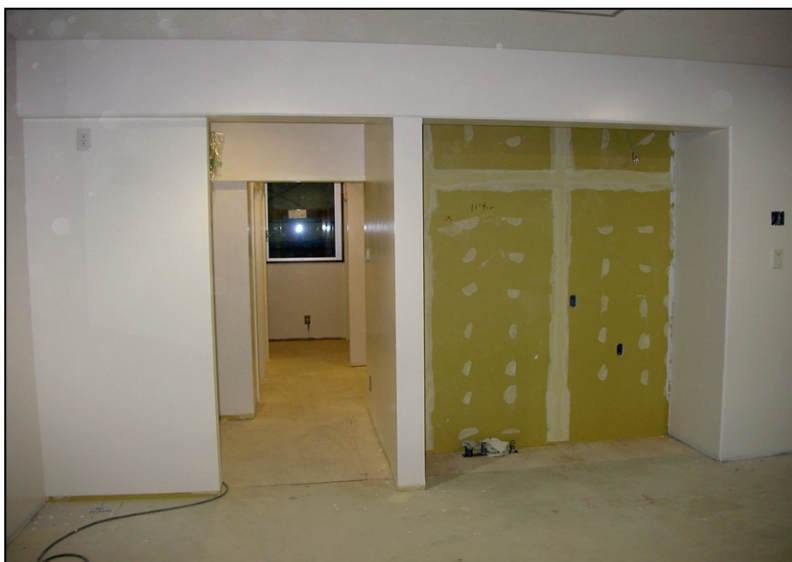
位置: 1F 水廻り室 撮影日: 令和3年11月16日
