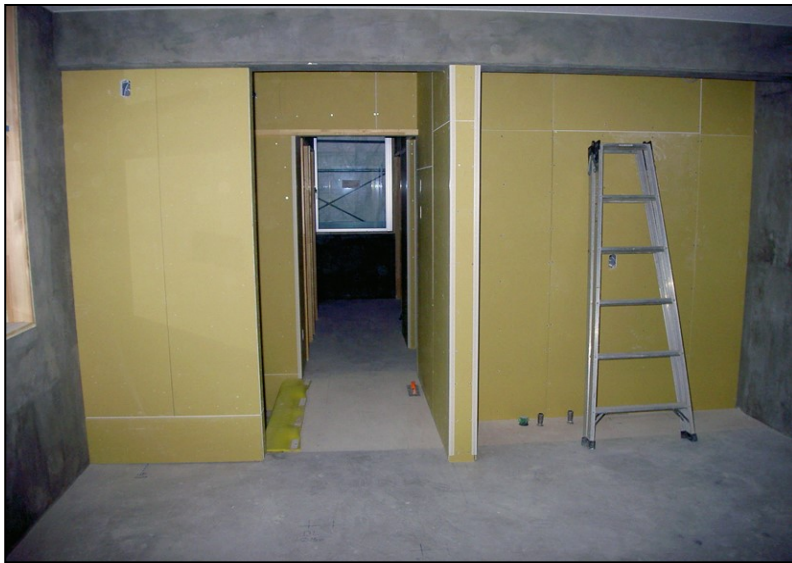
位置: 3F 水廻り室 撮影日: 令和3年11月16日
