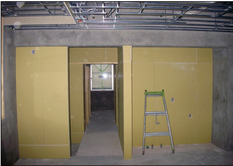
位置: 3F 水廻り室 撮影日: 令和3年11月9日
