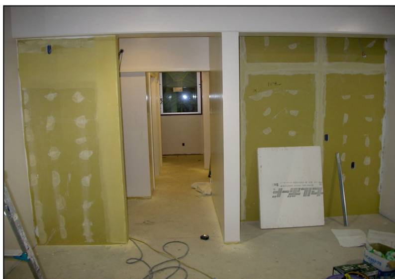
位置: 1F 水廻り室 撮影日: 令和3年11月9日 塗装工事: 壁ボード下地処理、塗装
