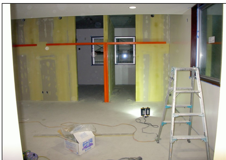
位置: 1F 交流スペース 撮影日: 令和3年11月9日 内装工事: クロス下地処理
