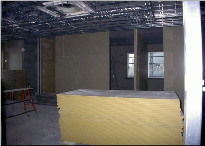
位置: 3F 交流スペース 撮影日: 令和3年11月4日 金属工事:天井LGS下地
