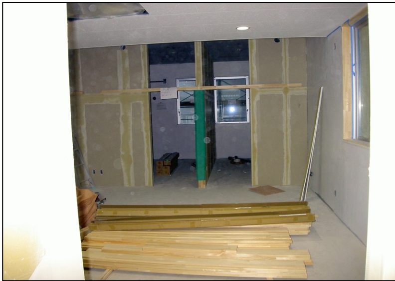
位置: 1F 交流スペース 撮影日: 令和3年11月4日 内装工事: 壁ボード下地処理
