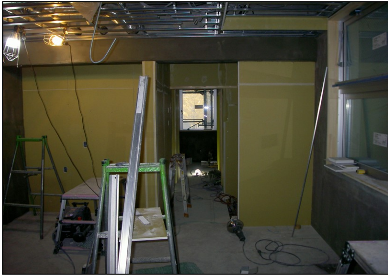
位置: 2F 水廻り室 撮影日: 令和3年11月2日 内装工事: 壁ボード張
