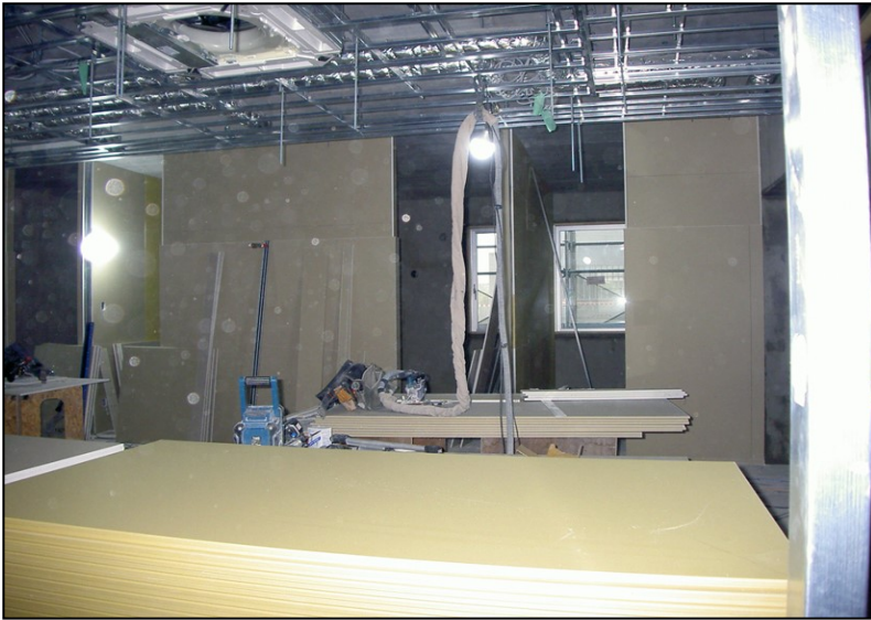
位置: 3F 交流スペース 撮影日: 令和3年11月2日 内装工事: 壁ボード張り
