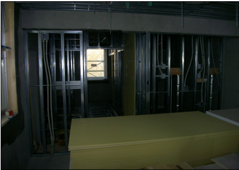
位置: 3F 水廻り室 撮影日: 令和3年11月2日 仕上ユニット工事: 鋼製床工事
