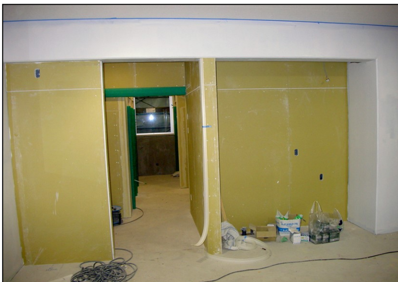
位置: 1F 水廻り室 撮影日: 令和3年10月27日
