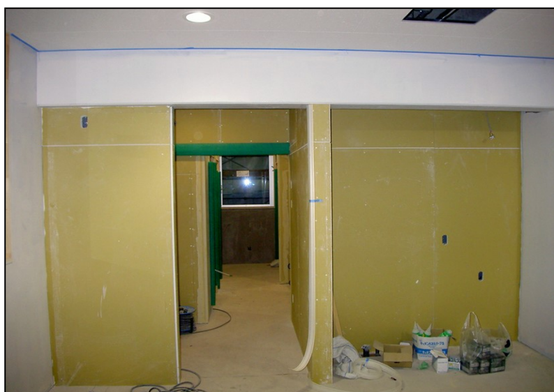
位置: 1F 水廻り室 撮影日: 令和3年10月28日
