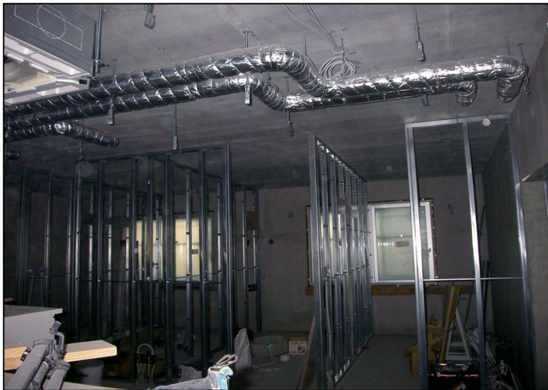
位置: 3F 交流スペース 撮影日: 令和3年10月28日 電気工事: 壁内配管
