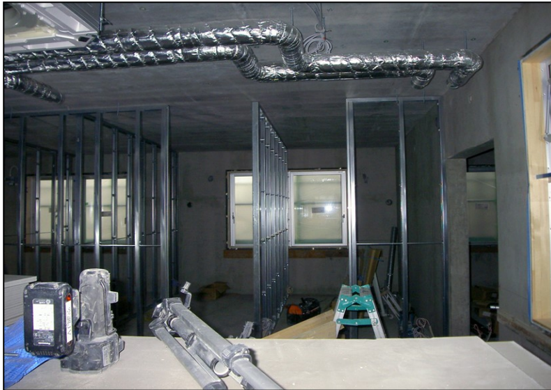
位置: 3F 交流スペース 撮影日: 令和3年10月27日 金属工事: 壁LGS下地組
