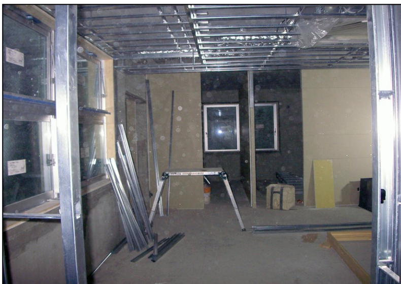
位置: 2F 交流スペース 撮影日: 令和3年10月28日 金属工事: 天井LGS下地組
