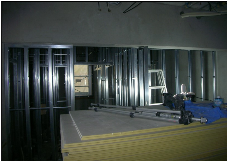
位置: 3F 水廻り室 撮影日: 令和3年10月27日 金属工事: 壁LGS下地組
