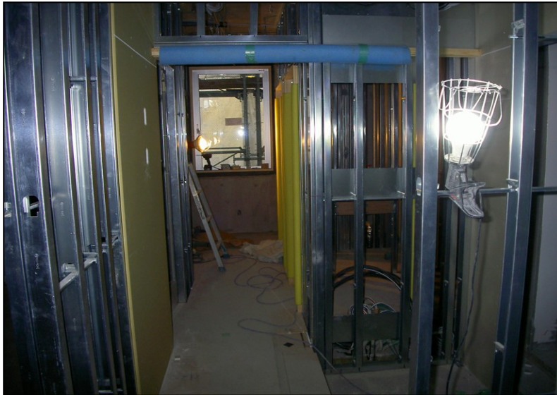
位置: 2F 水廻り室 撮影日: 令和3年10月27日 木工事: 木製建具枠取付
