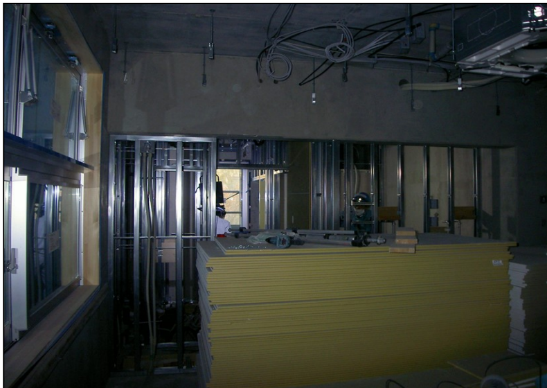
位置: 3F 水廻り室 撮影日: 令和3年10月28日 電気工事: 壁内配管
