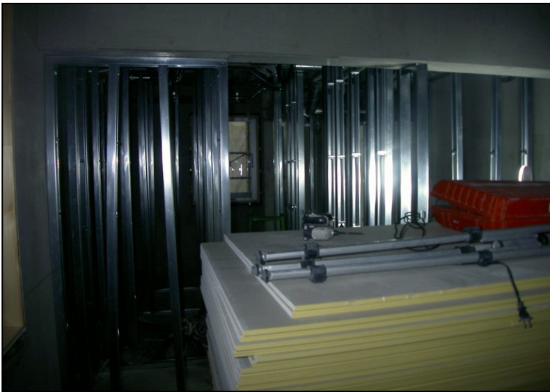
位置: 3F 水廻り室 撮影日: 令和3年10月26日 金属工事: 壁LGS下地組
