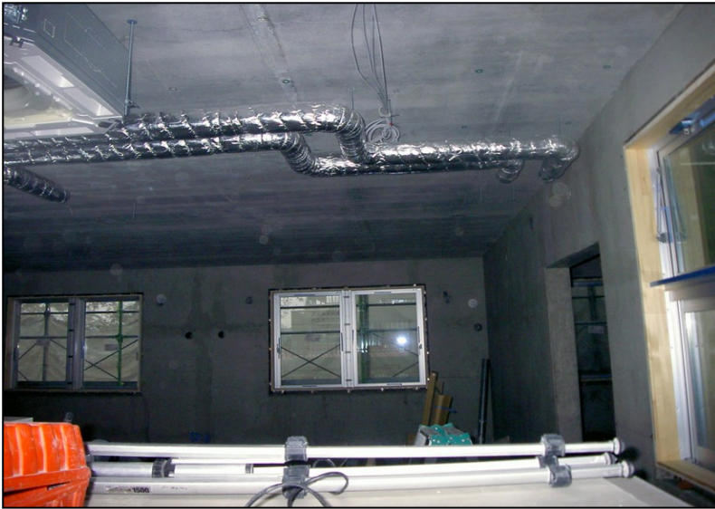
位置: 3F 交流スペース 撮影日: 令和3年10月26日 金属工事: 壁LGS下地組
