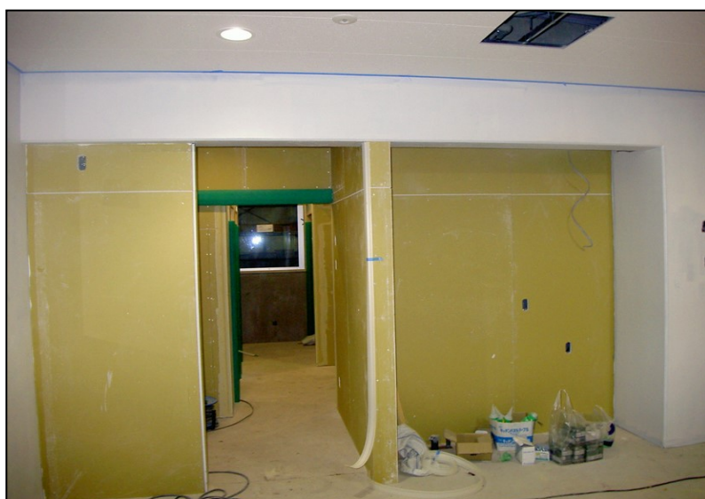
位置: 1F 水廻り室 撮影日: 令和3年10月26日
