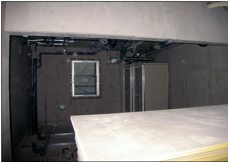
位置: 3F 水廻り室 撮影日: 令和3年10月25日 設備工事: 床下給排水配管
