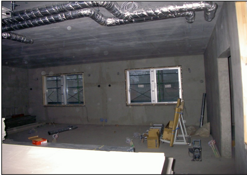
位置: 3F 交流スペース 撮影日: 令和3年10月25日 木工事: 窓額縁取付
