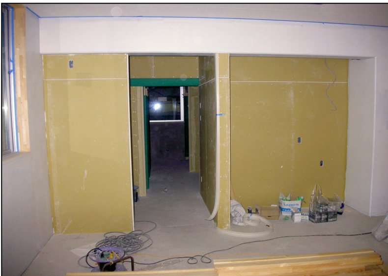
位置: 1F 水廻り室 撮影日: 令和3年10月25日
