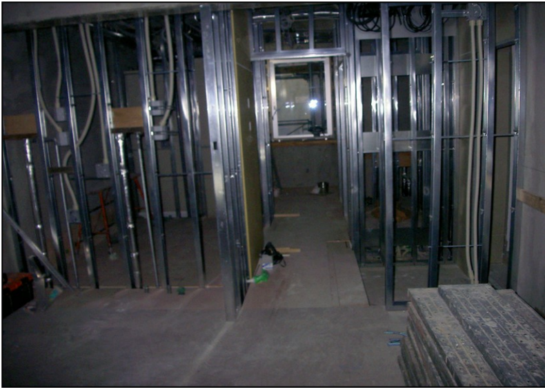
位置: 2F 水廻り室 撮影日: 令和3年10月25日
