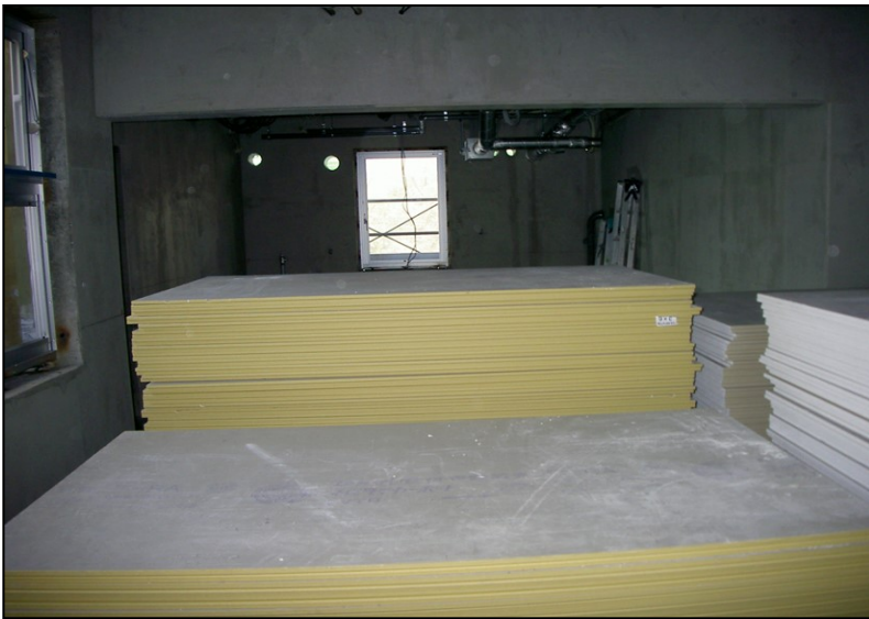
位置: 3F 水廻り室 撮影日: 令和3年10月19日 設備工事:ダクト工事
