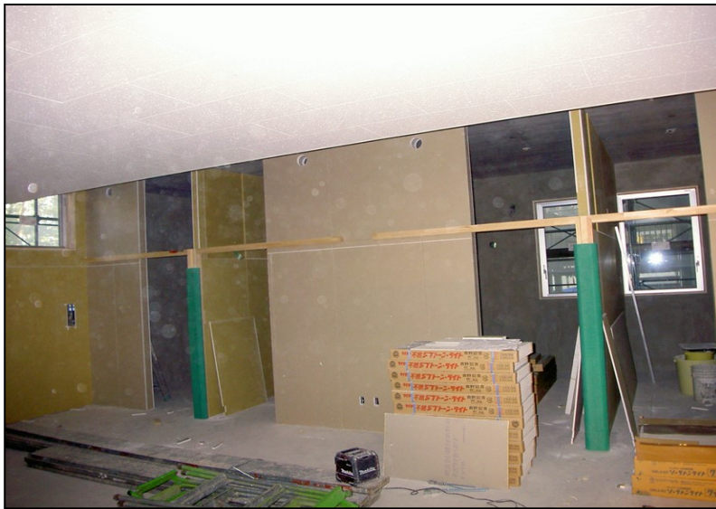
位置: 1F 交流スペース 撮影日: 令和3年10月19日 内装工事: 天井ボード張り
