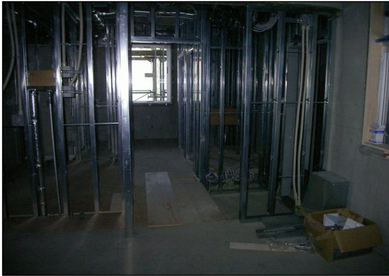
位置: 2F 水廻り室 撮影日: 令和3年10月19日 仕上ユニット: 鋼製床工事
