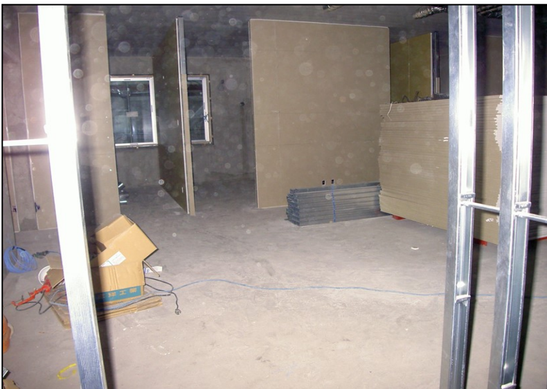
位置: 2F 交流スペース 撮影日: 令和3年10月19日 内装工事:壁ボード張り
