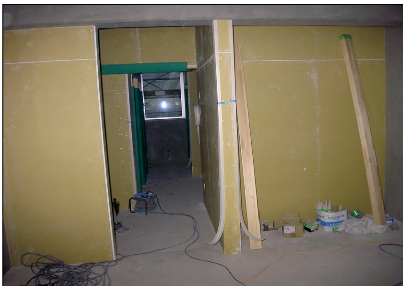
位置: 1F 水廻り室 撮影日: 令和3年10月19日
