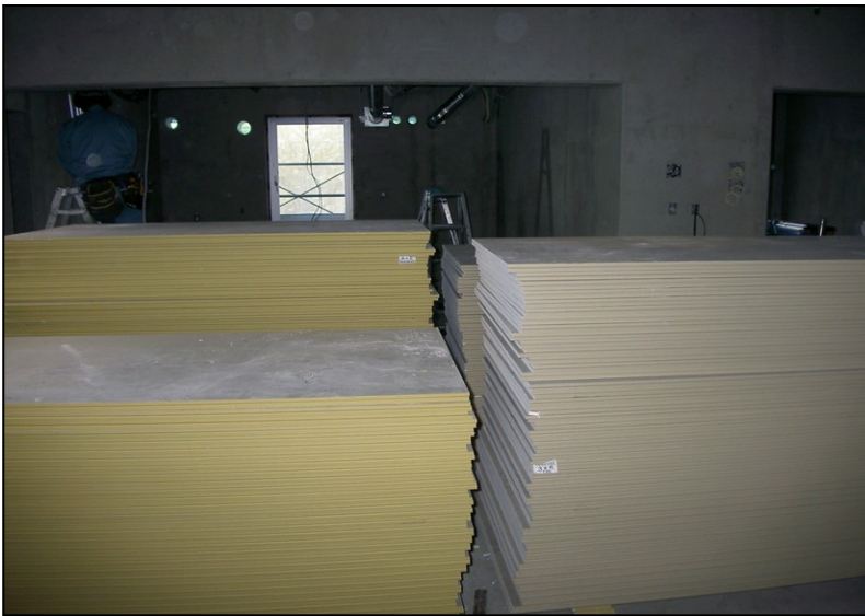
位置: 3F 水廻り室 撮影日: 令和3年10月18日 電気工事: 配線
