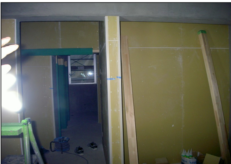
位置: 1F 水廻り室 撮影日: 令和3年10月18日
