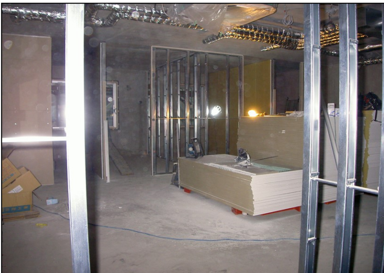
位置: 2F 交流スペース 撮影日: 令和3年10月18日 内装工事: 壁ボード張り
