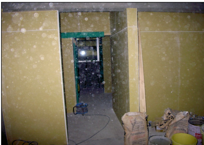
位置: 1F 水廻り室 撮影日: 令和3年10月13日
