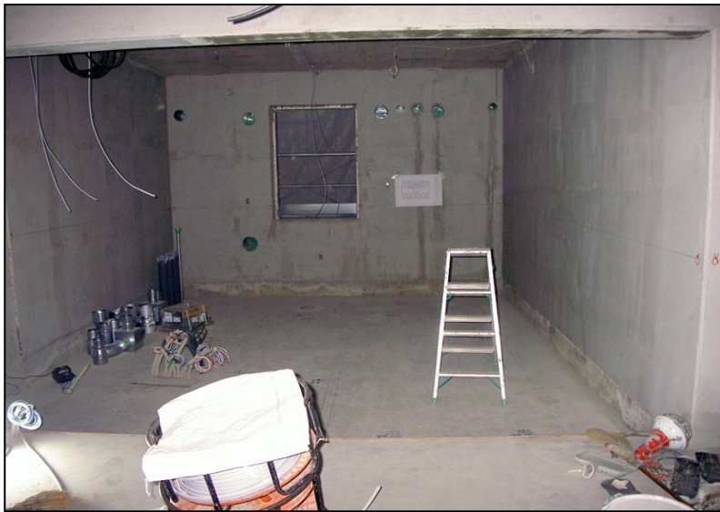
位置: 3F 水廻り室 撮影日: 令和3年10月13日 電気工事: 配線工事
