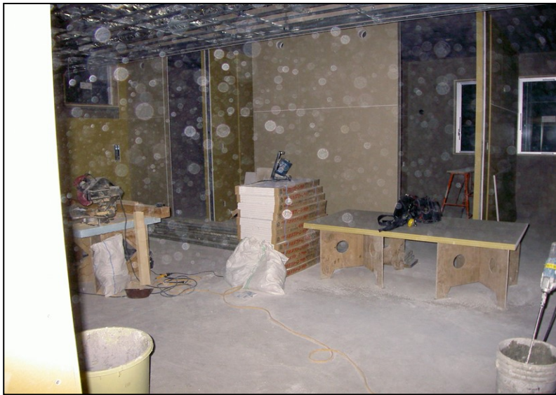
位置: 1F 交流スペース 撮影日: 令和3年10月13日 内装工事: 壁ボード張り
