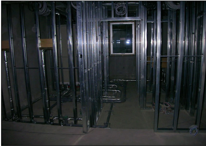
位置: 2F 水廻り室 撮影日: 令和3年10月13日
